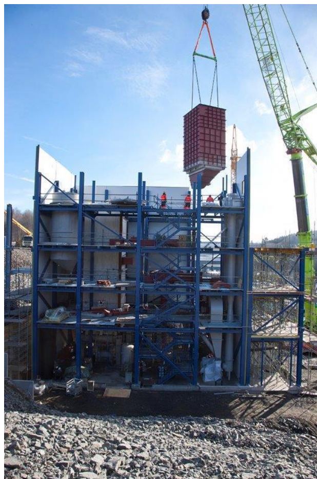
Bild: Rottneros Bruks nya bibränslepanna under konstruktion
