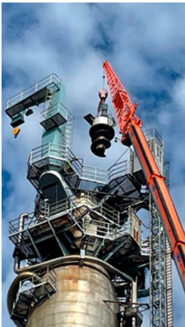
Toppseparator lyfts ur kokaren på Vallviks Bruk vid underhållsstoppet.
